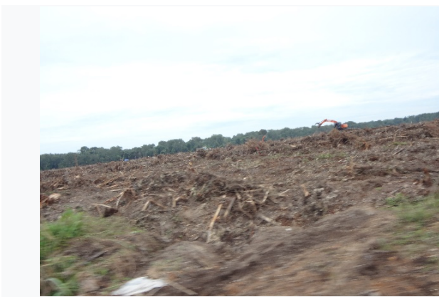
公園内の土地を整地する重機
