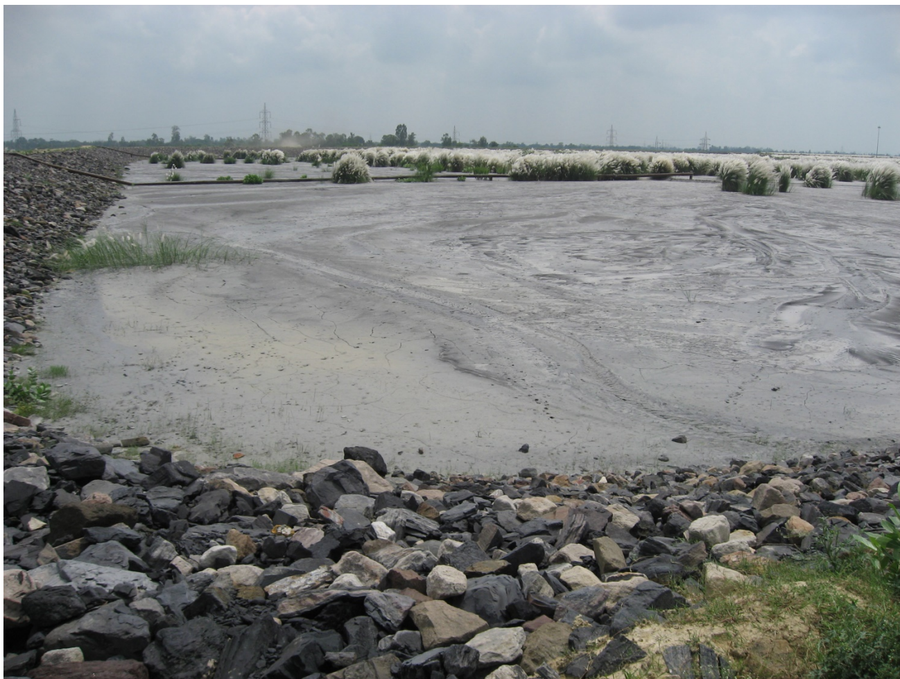
インド・タンダ石炭火力発電所の焼却灰処分場
