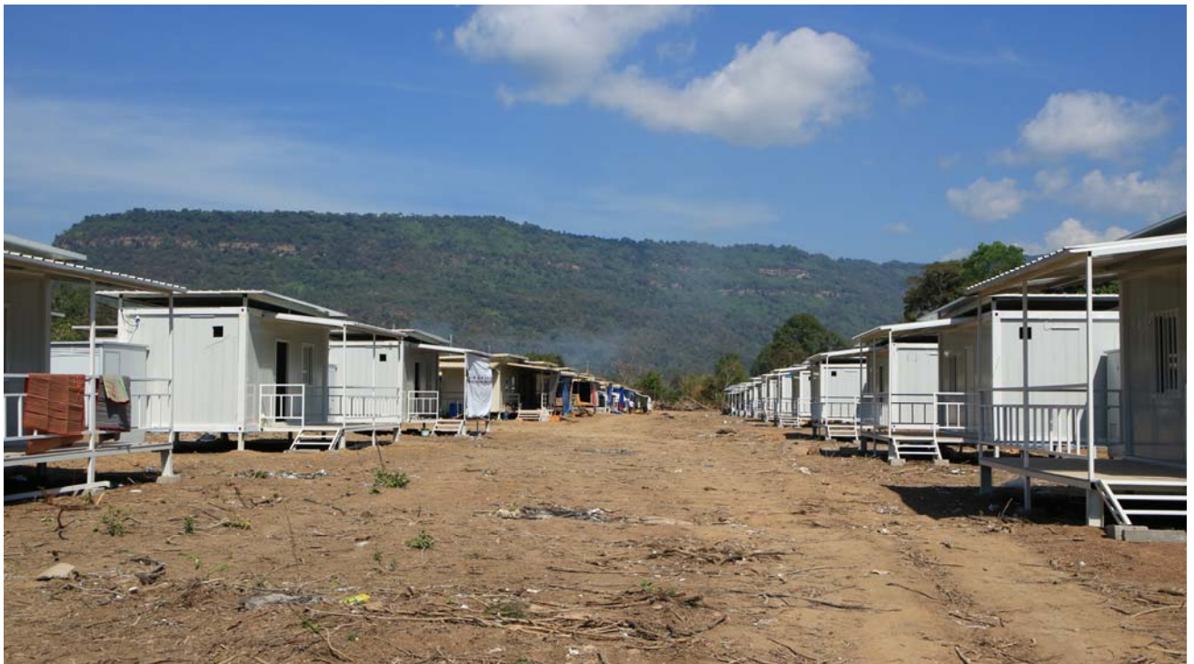
避難所の仮設住宅（メコン・ウォッチ撮影 2018 年 12 月）
