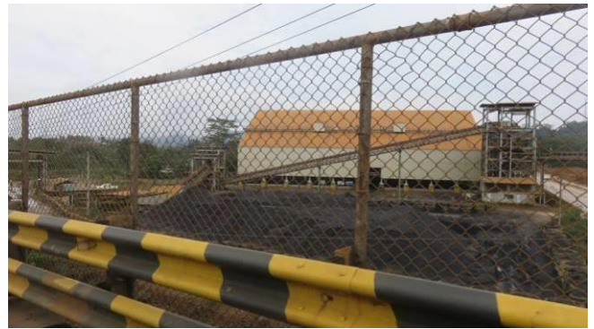
PTVI のニッケルマット製造設備の敷地内にある石炭貯蔵場（2022 年 7 月）
