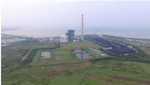
写真：2012年から商業運転を開始した1号機。 (インドネシア環境フォーラム・西ジャワ。 2016年10月)
