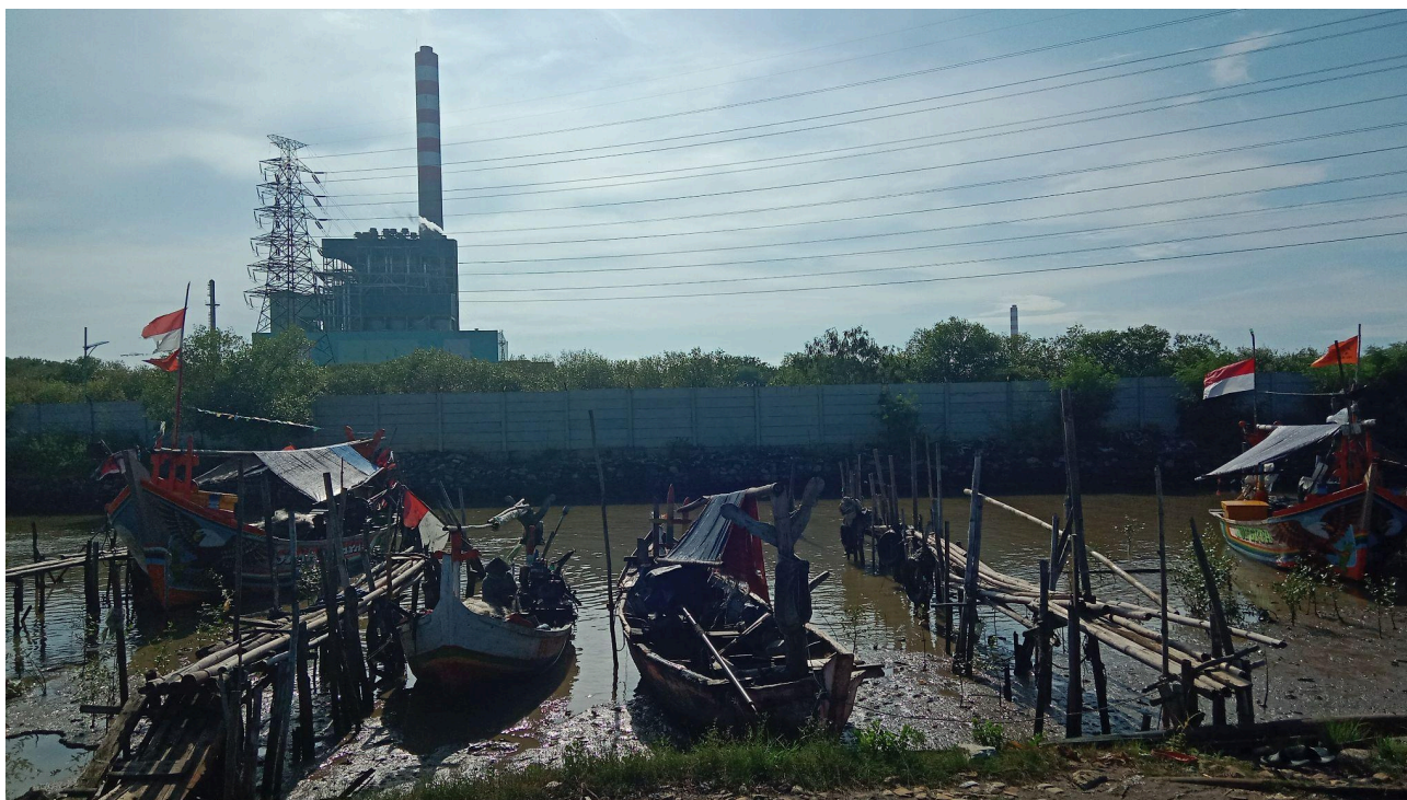
写真: ワルドウウル村の漁船が停泊する漁港と2012年から稼働しているチレボン石炭火力発電所1号機(FoE Japan。2024年4月)
